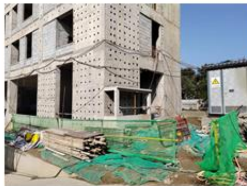
项目建设现状
