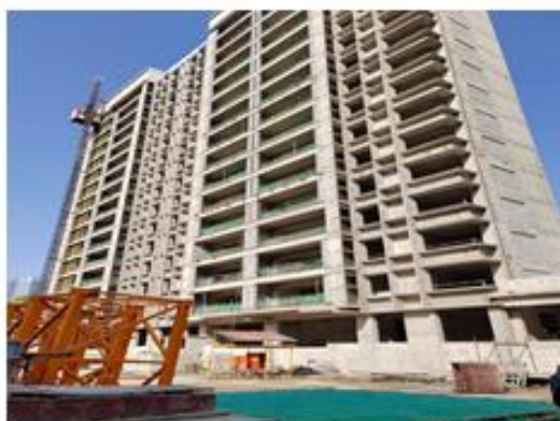
项目建设现状
