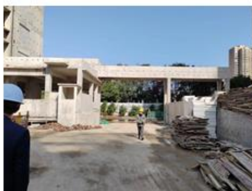
项目建设现状
