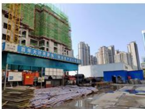
施工临时设施区
