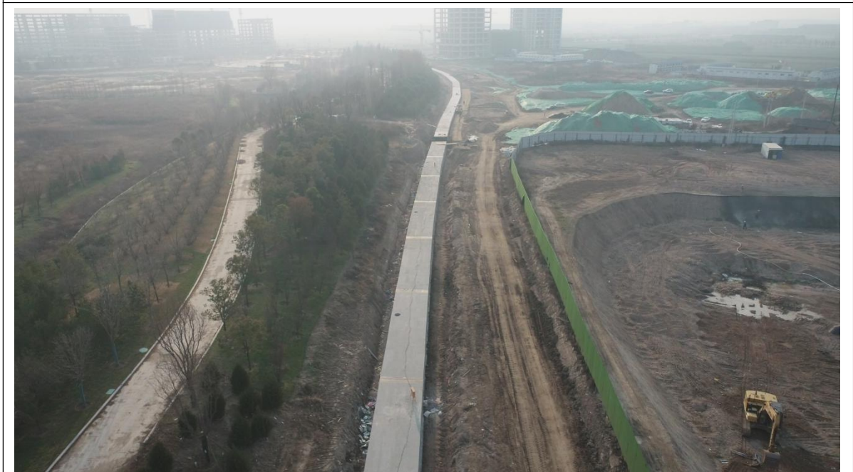
项目区航拍俯视图（镜向南）
