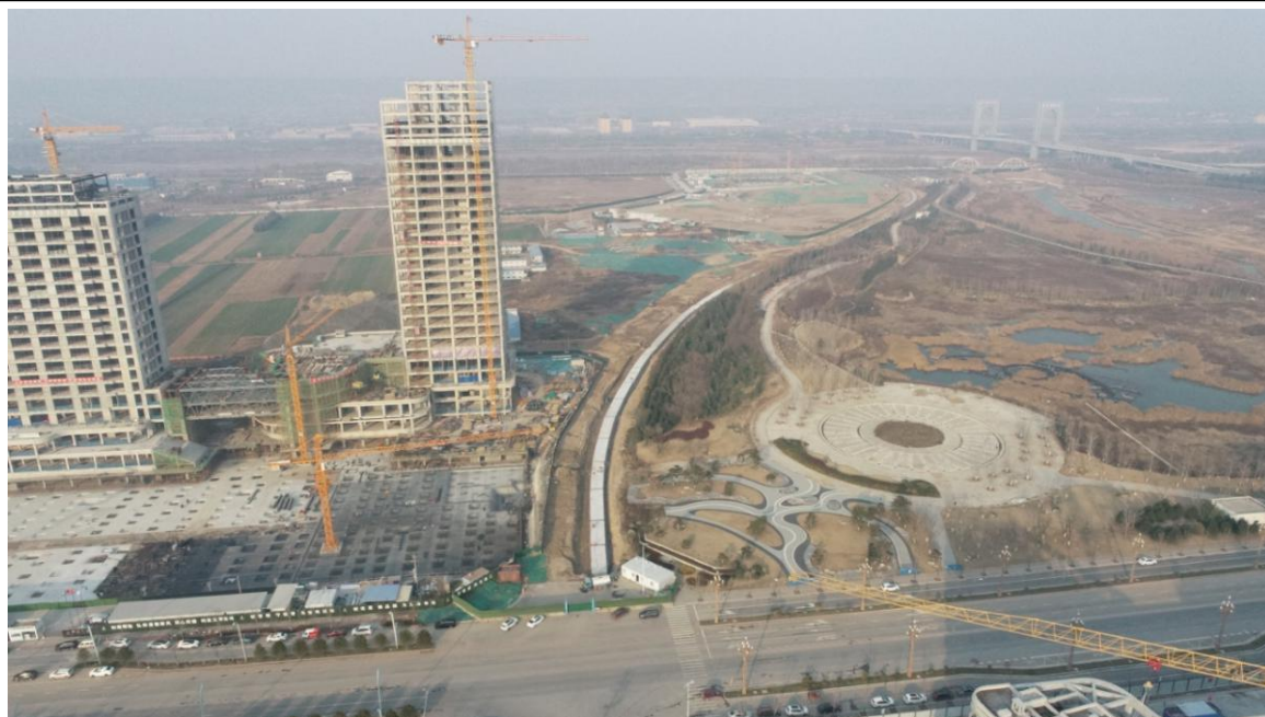
项目区航拍俯视图（镜向北）
