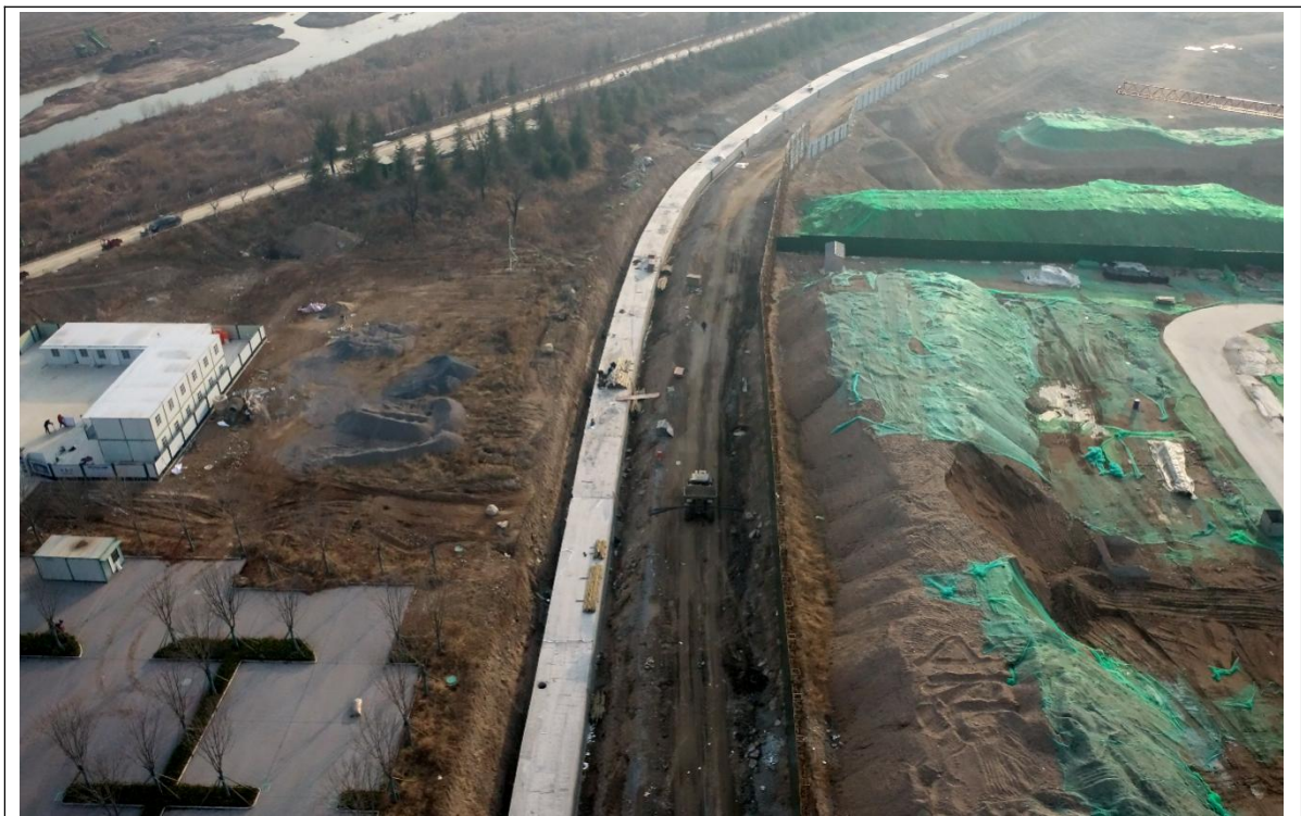
项目区航拍俯视图（镜向南）
