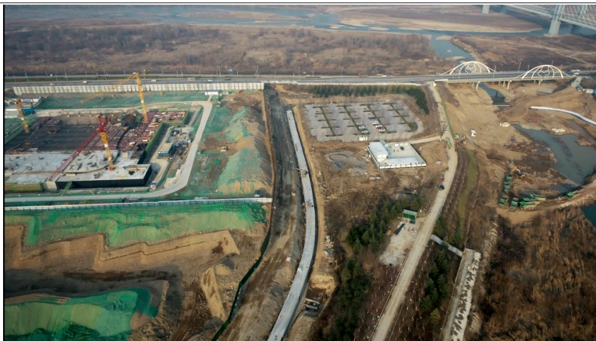
项目区航拍俯视图（镜向北）
