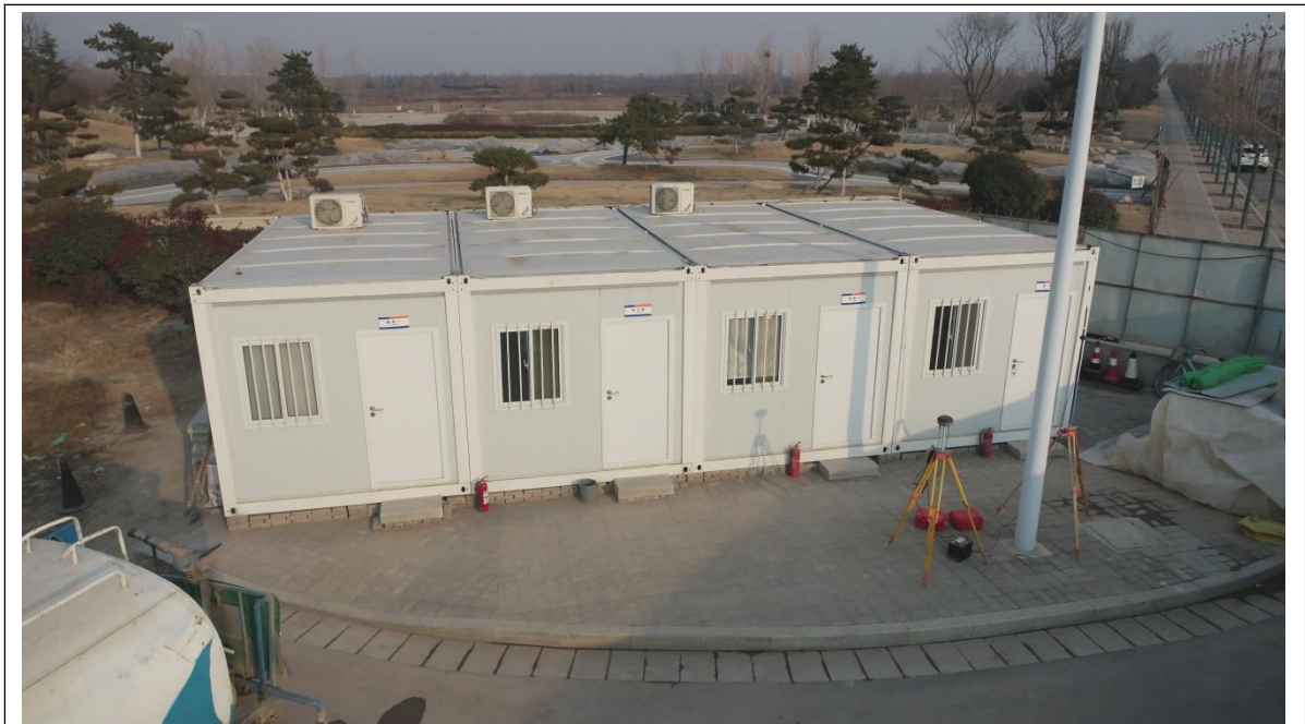
施工生产生活区
