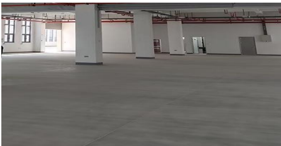
图 3-1 项目厂房地面硬化处理照片
