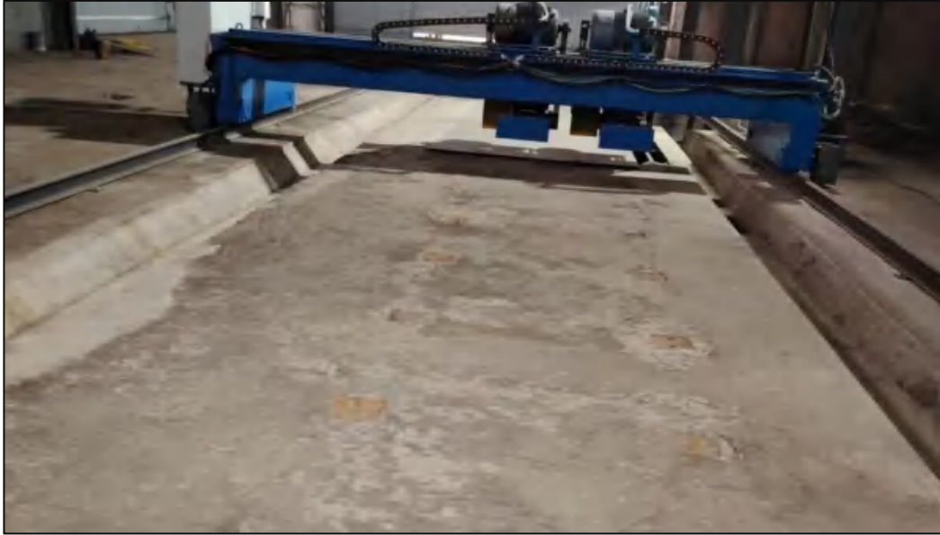
图 3-1 项目厂区地面硬化状况
