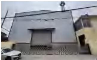
厂房外部现状
