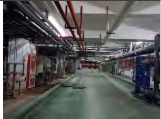
污水处理设施 2
