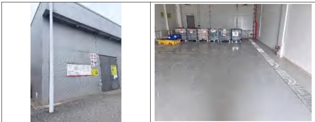
现有危废贮存库照片
