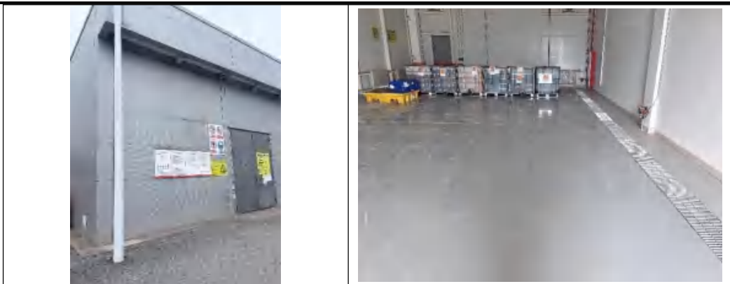
现有危废贮存库照片
