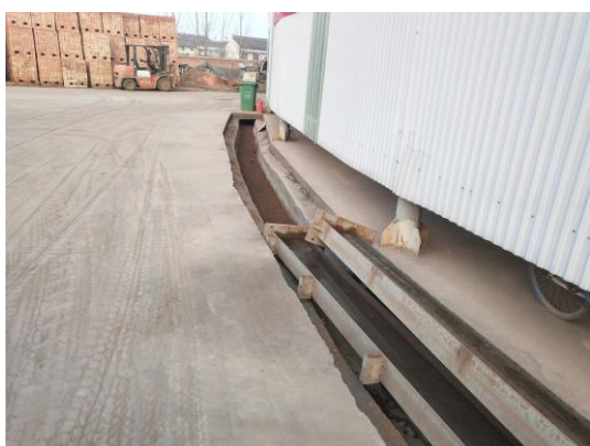
生产加工区排水沟
