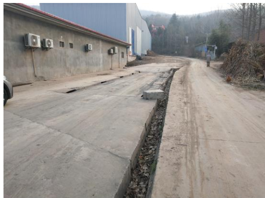
地块西侧道路排水沟现状
