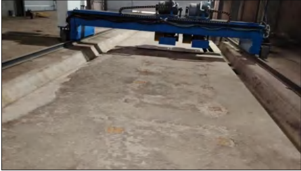
图 3-1 项目厂区地面硬化状况
